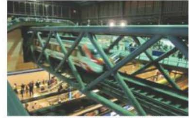
Intercambiador de la estación de Príncipe Pío. Madrid, España.
