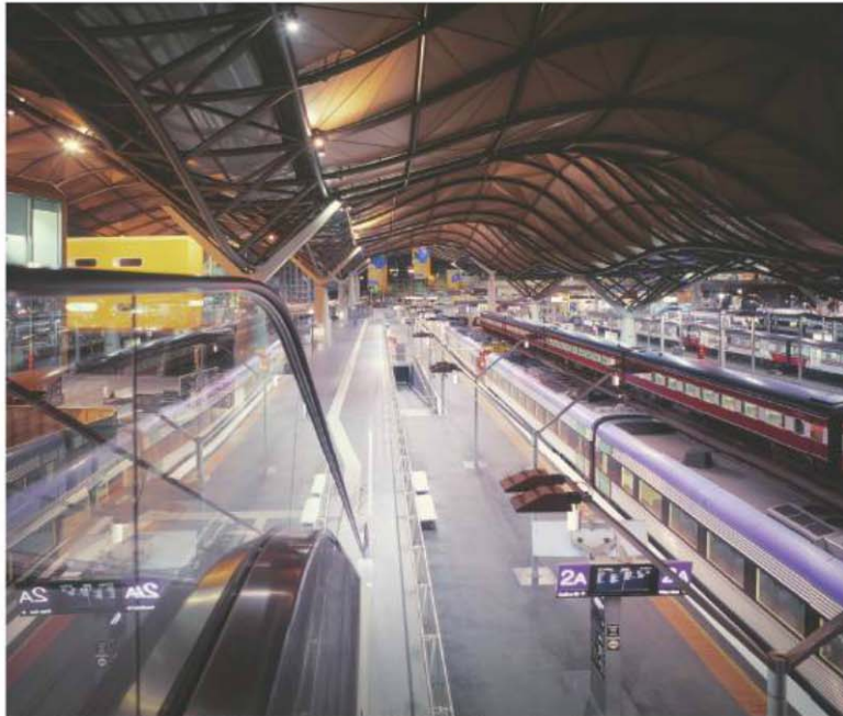
Trenes listo para la salida en la estación futura de Southern Cross en Melbourne, Australia.
