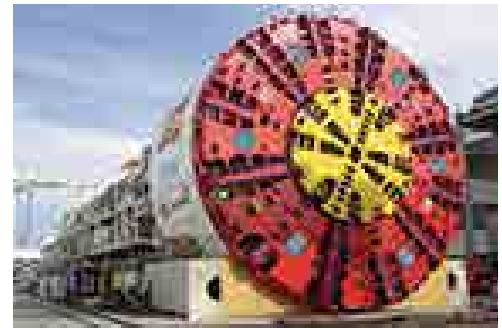
Tuneladora E.P.B. Ø 15 m. empleada en los túneles del Bypass Sur Madrid.
