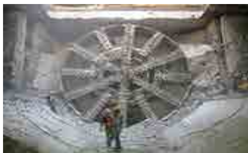
Tuneladora empleada en la Línea 12 del Metro de la Ciudad de México.
