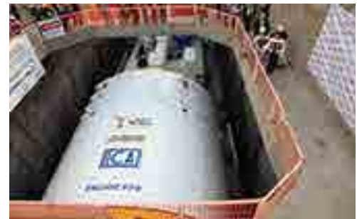
Imagen del "escudo" empleado en la Línea 12 del Metro de la Ciudad de México.
